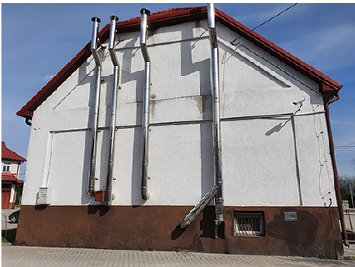
FOT. 2 ELEWACJA POŁUDNIOWO-ZACHODNIA
