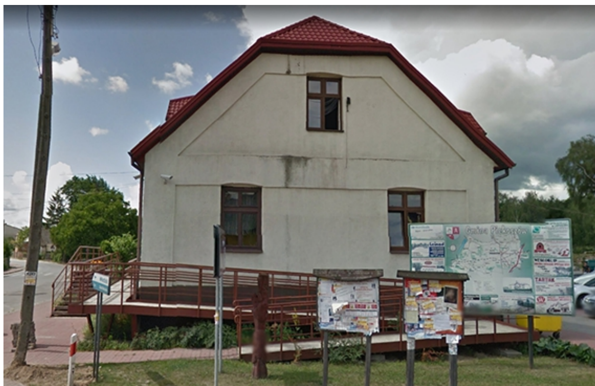
FOT. 4 ELEWACJA PÓŁNOCNO-ZACHODNIA
