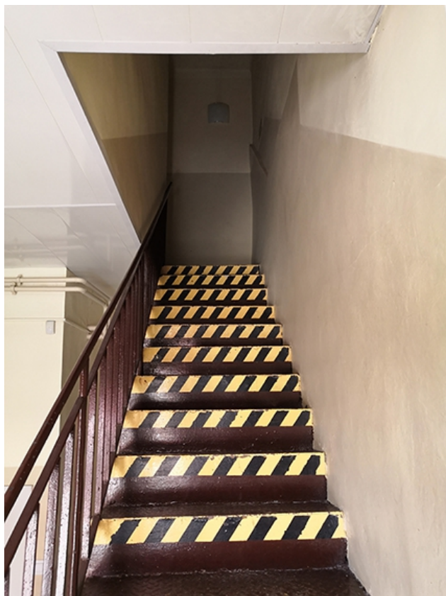
FOT. 13 SCHODY STALOWE
