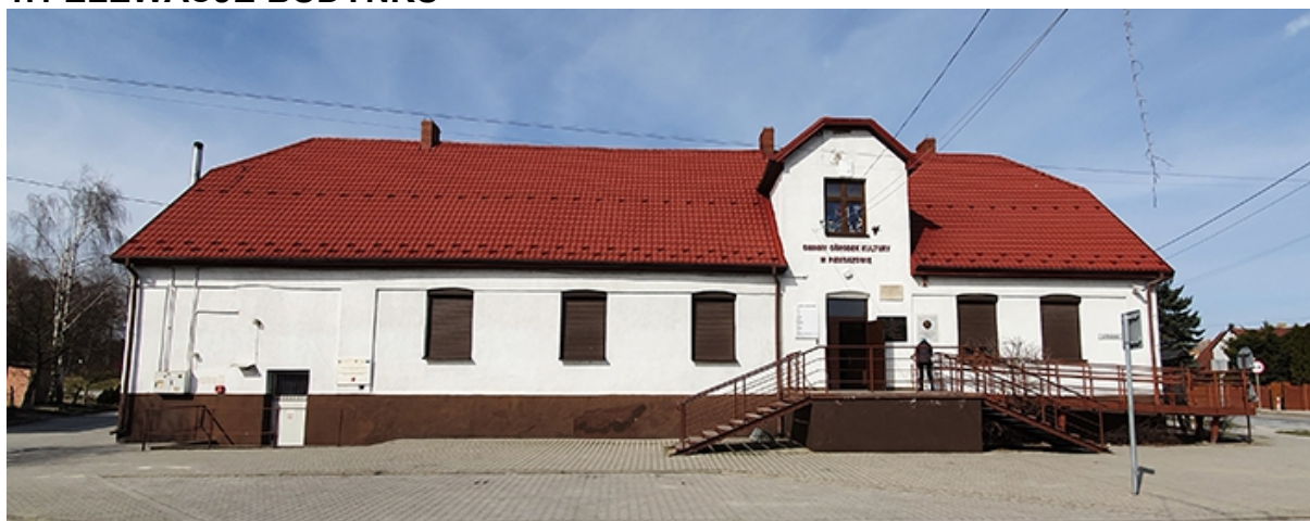
FOT. 1 ELEWACJA FRONTOWA POŁUDNIOWO-WSCHODNIA
