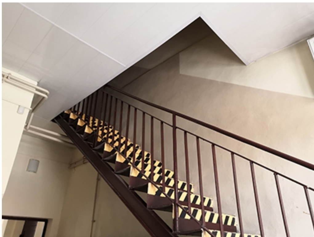
FOT. 14 SCHODY STALOWE
