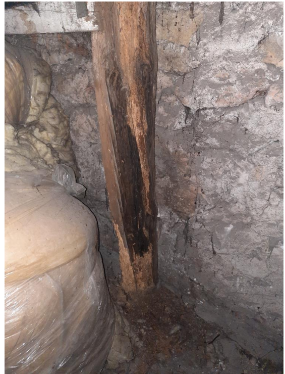
Korozja słupka więźby dachowej
