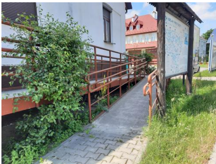
Widok pochylni dla niepełnosprawnych – konstrukcja stalowo-żelbetowa
