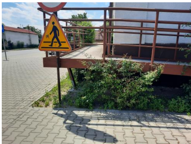
Widok pochylni dla niepełnosprawnych – konstrukcja stalowo-żelbetowa
