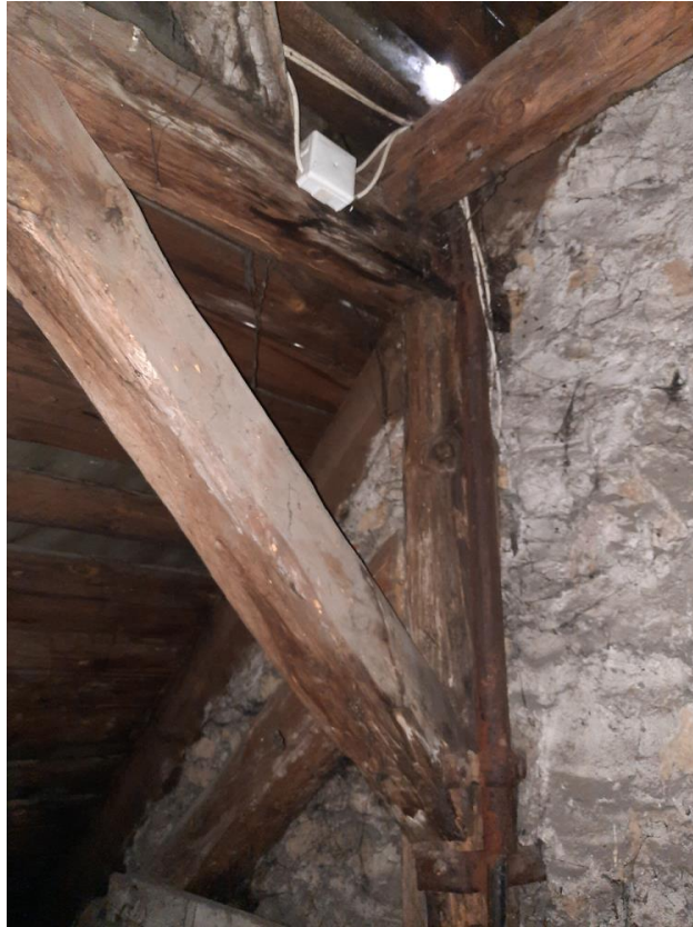
Nieszczelności dachu, zamakanie elementów
