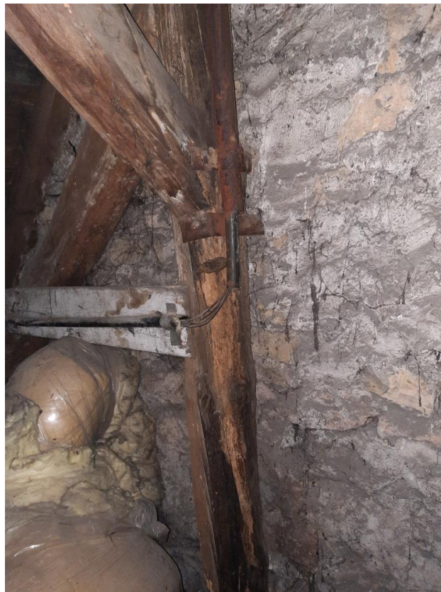
Korozja słupka więźby dachowej
