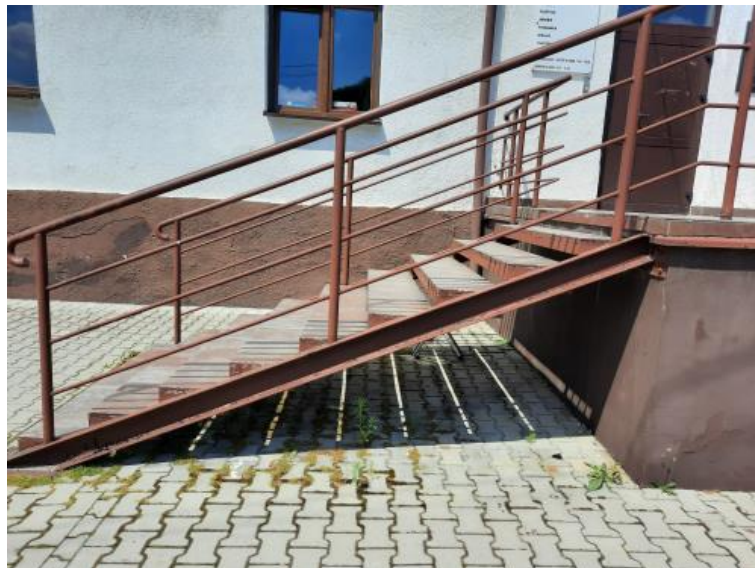
Schody przy wejściu głównym – konstrukcja stalowa z betonowymi stopniami
