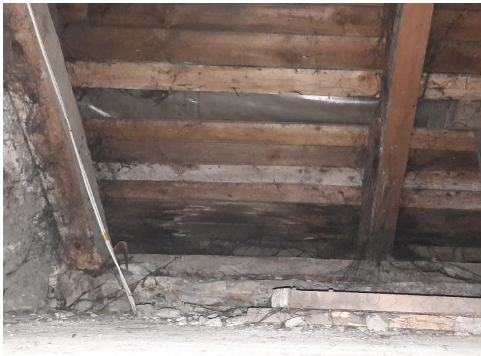
Lokalna korozja biologiczna przy części okapowej
